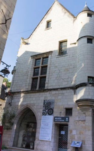
Maison des États généraux, façade sur rue
