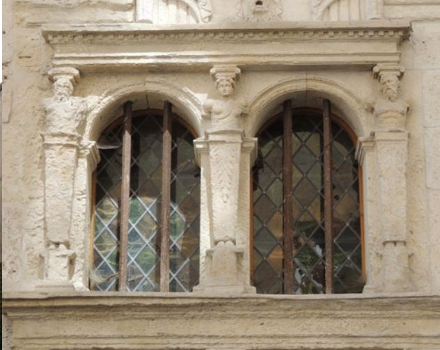
Sur la façade de la maison de la Coquille, trois termes délimitent les deux jours d'imposte de la porte d'entrée et supportent un entablement
