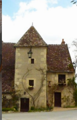
Maison des Mariniers en pierre calcaire d'Apremont
