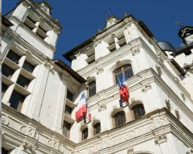
Hôtel de Ville : une façade quelque peu remaniée lors des restaurations du début du XX e siècle
