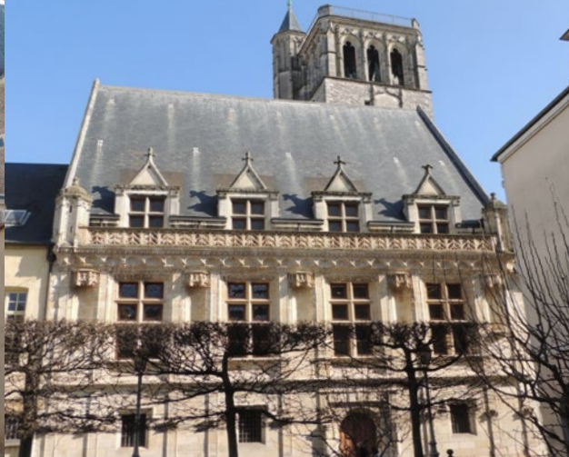
L'étage noble de l'hôtel des Créneaux est ouvert sur la rue par des grandes baies à doubles traverses, flanquées de pilastres finement cannelés
